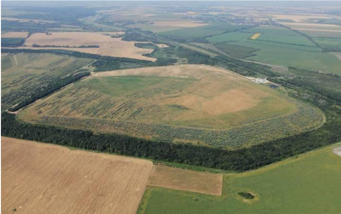
M.7.3 – 2. ábra Rekultivált uránipari zagytározó
