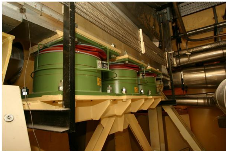
2-4. ábra: Viszkózus rezgéscsillapítóval végrehajtott megerősítés
