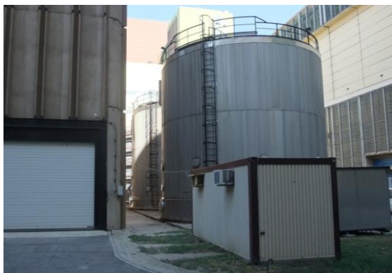
2-5. ábra: A II. kiépítés sótalanvíztartályai az egészségügyi és laborépület fala mellett
